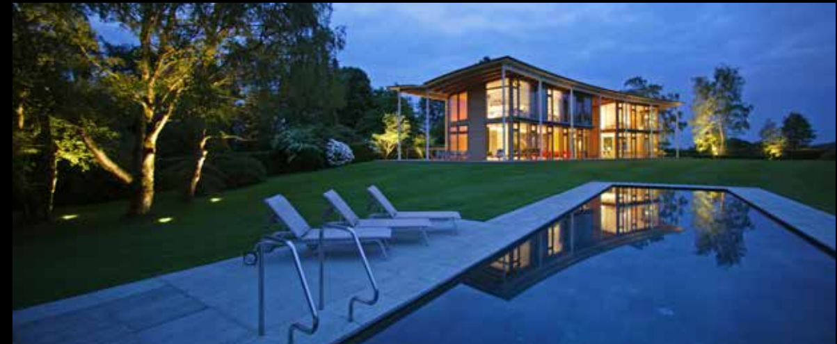
Residencia particular cerca de Düsseldorf. Arquitectura: ingenhoven architects, Düsseldorf (Alemania). Diseño de iluminación: Tropp Lighting Design, Weilheim (Alemania). Fotografía: Frieder Blickle, Hamburgo (Alemania).
